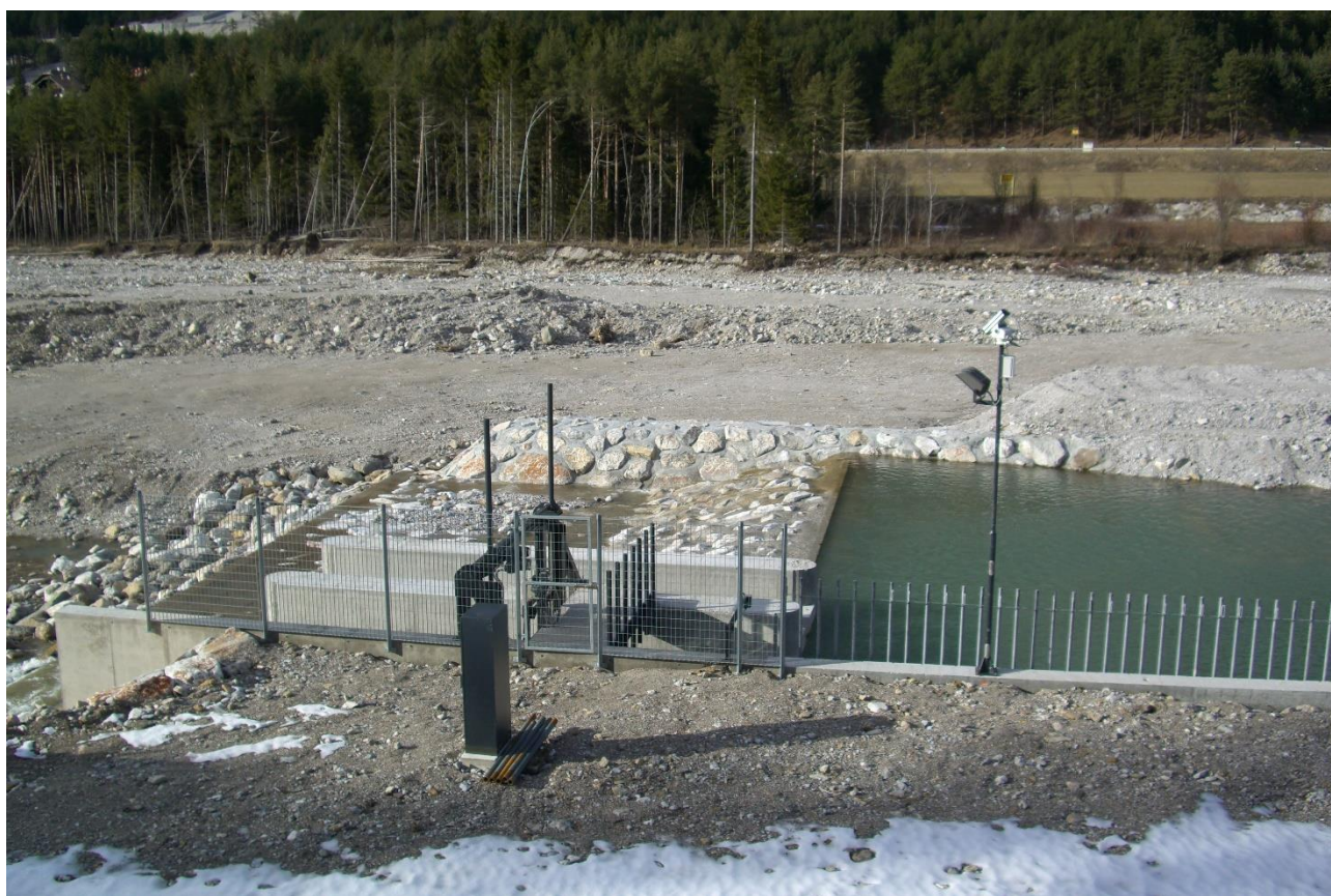
Fig. 13 Centralina idroelettrica in costruzione (bacino del Tagliamento)
