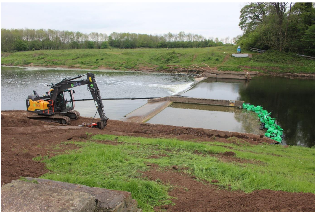
Fig. 32 Samesbury Weir, fiume Ribble (Gran Bretagna). Un escavatore che sta per iniziare il lavoro con la cortina di sabbia sul posto e una barriera di sacchi di sabbia per contenere il cemento rotto (maggio 2020).
