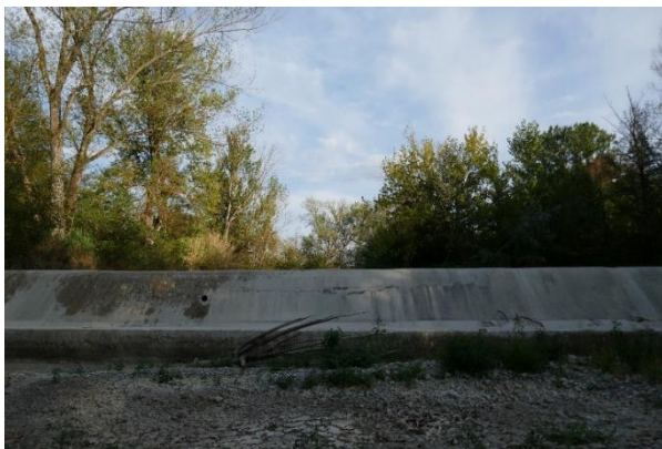
Fig. 22 Ponte di via Palazzetti 3
