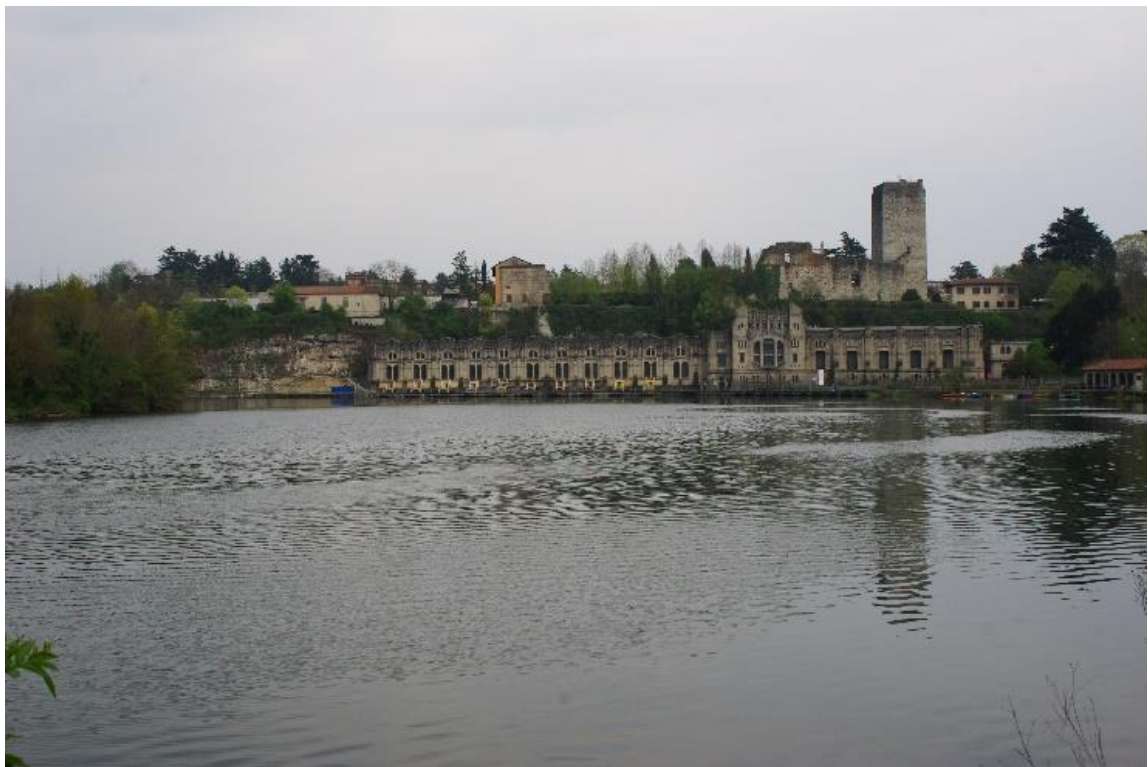
Fig. 4 Sbarramento sull'Adda. Centrale idroelettrica Taccani (Trezzo d'Adda)
