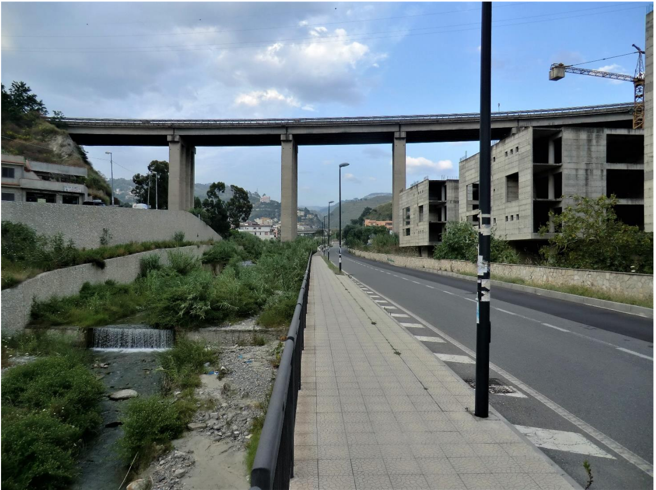
Corso d'acqua canalizzato e degrado urbanistico
