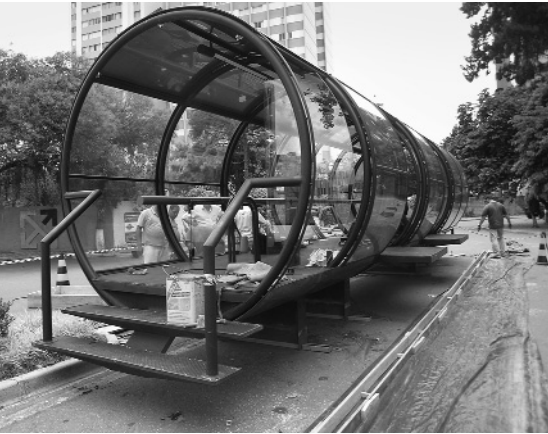
Una pensilina in costruzione alla fermata dell'autobus a Curitiba, Brasile (© Morio).
