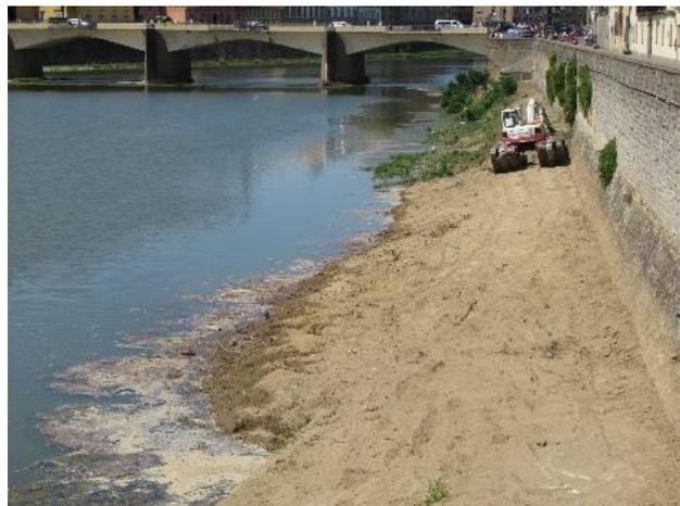
**Figg.59 e 60. Fiume Arno (FI) 22.10.2019.** Taglio e rimozione sedimenti fluviali e vegetazione a cura del Consorzio di Bonifica 3 Medio Valdarno. Utilizzo di escavatore anfibia a valle di Ponte Vecchio fino alla Pescaia di Santa Rosa
