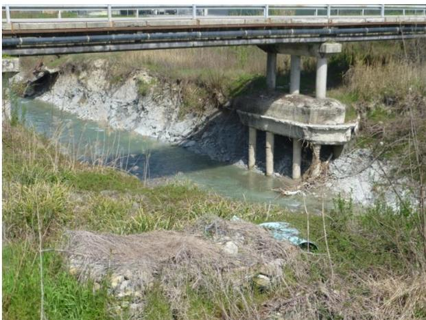
**Fig.24.** 27.3.2016, ponte di V. Serrabella; il pericolo per la stabilità del ponte risulta evidente: si noti l'erosione e incisione dell'alveo
