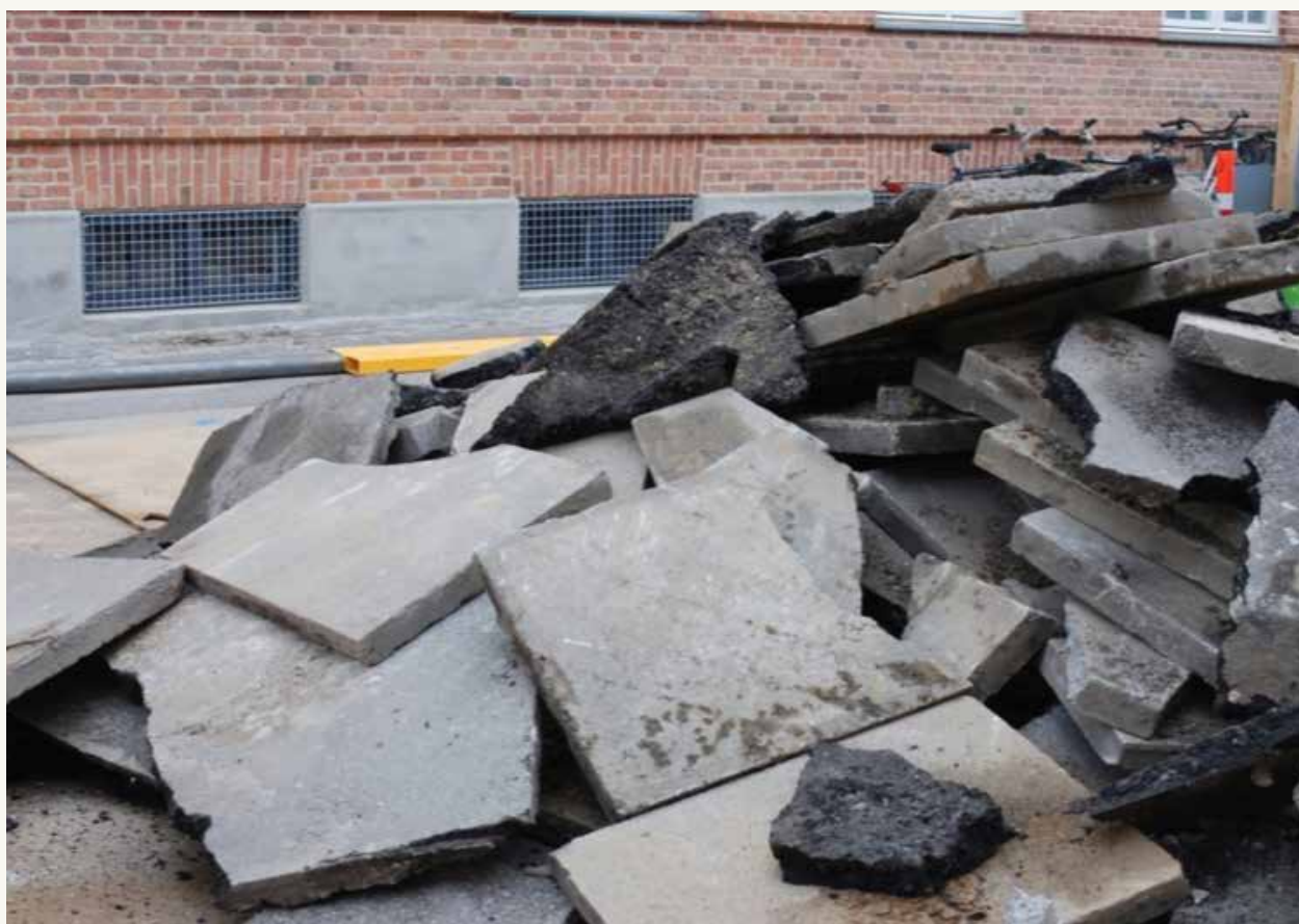
Fig. 5.4.: Gli interventi di adattamento climatico urbano comportano spesso la eliminazione di superfici asfaltate e la loro sostituzione con suoli ecologicamente attivi (Copenhagen, foto dell'autore)
